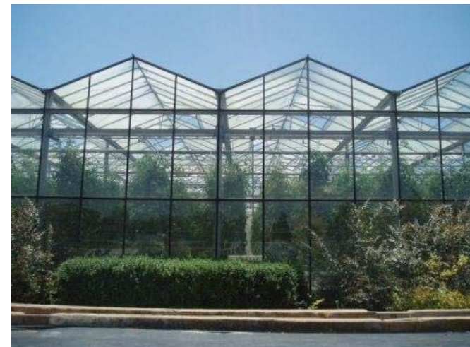
Foto 4. Invernadero tipo venlo con cubierta de vidrio
