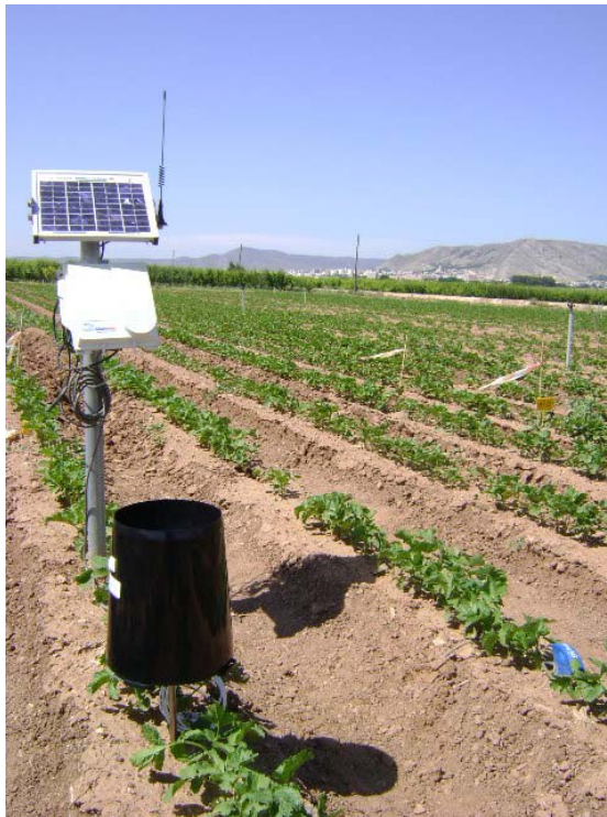
Equipo completo: sonda junto con fuente de alimentación y módem; delante pluviómetro
